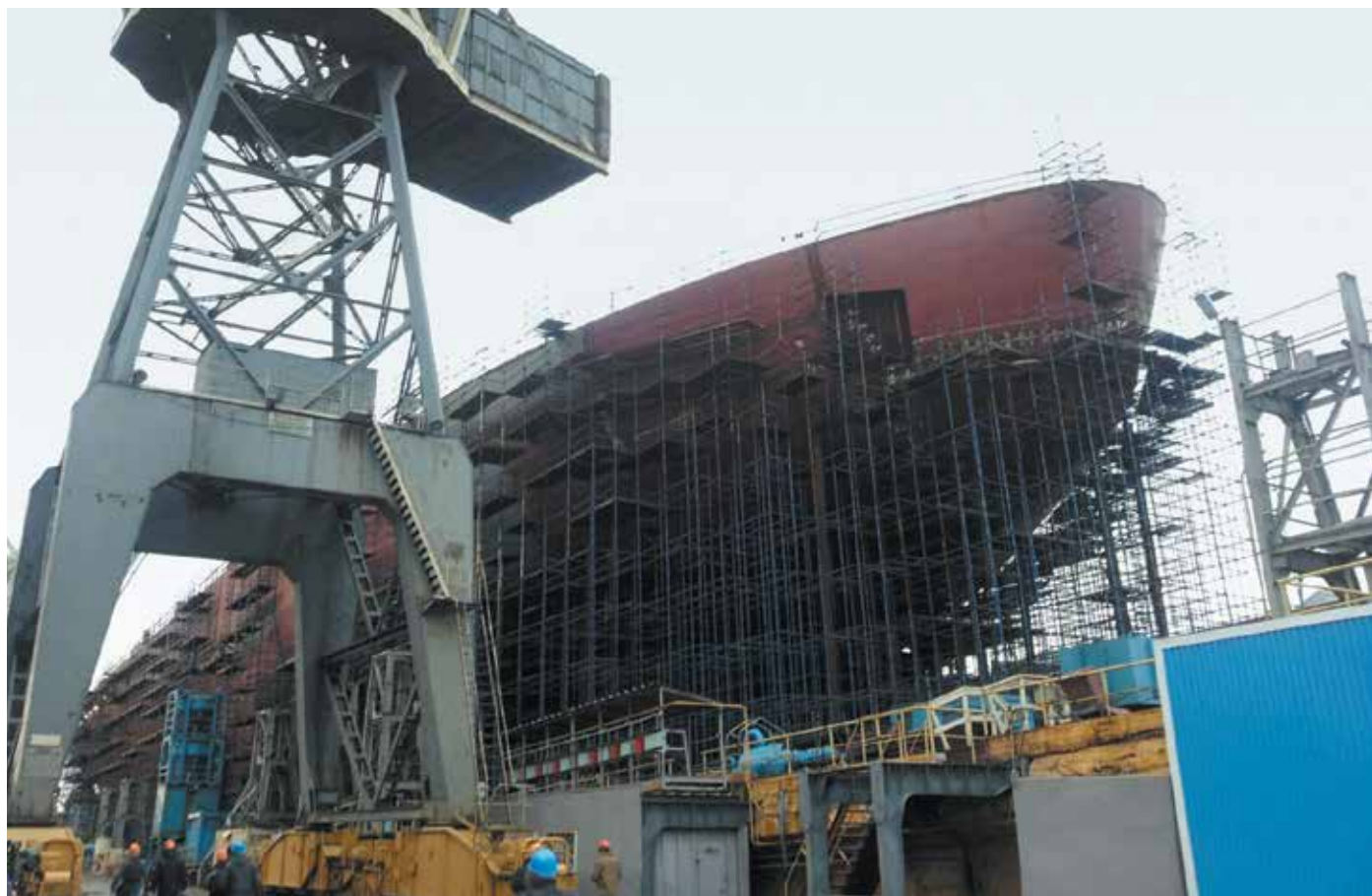
Строительство ледокола «Арктика» на Балтийском заводе
