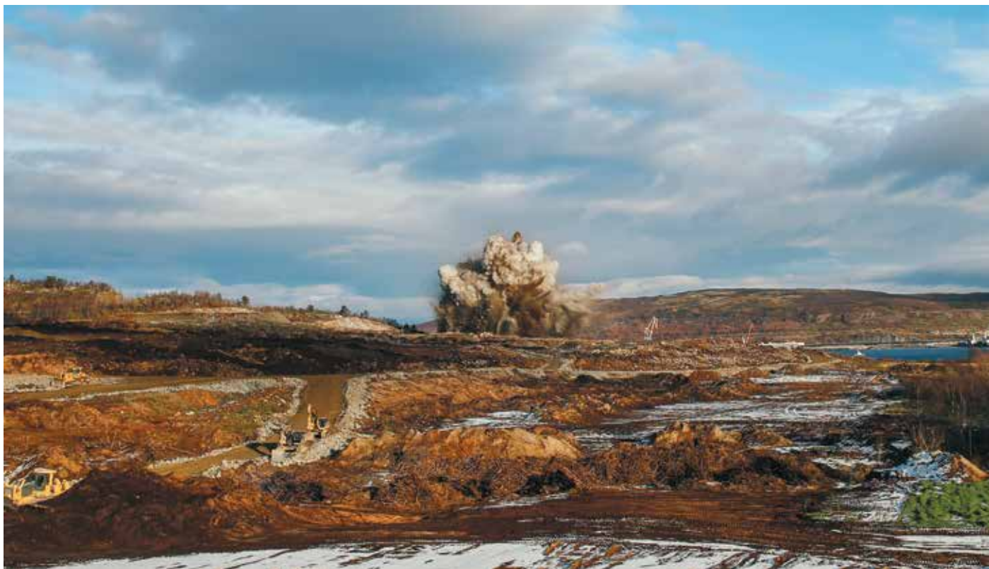
Обустройство площадки под угольный терминал. Взрыв скальной породы в объеме 15 тысяч кубометров
