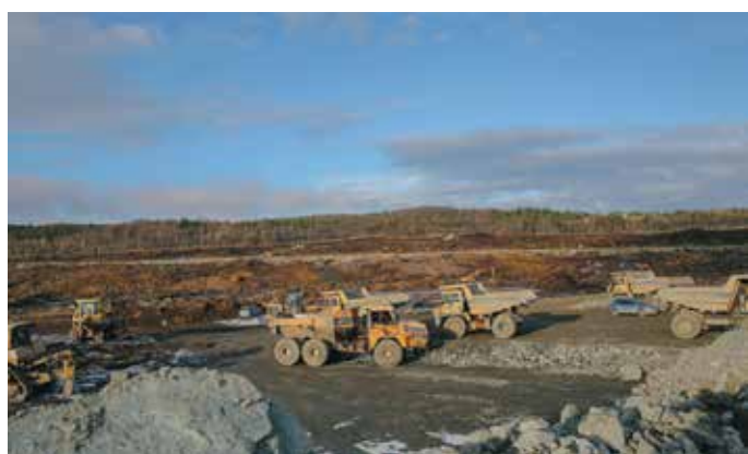
Обустройство площадки под угольный терминал
