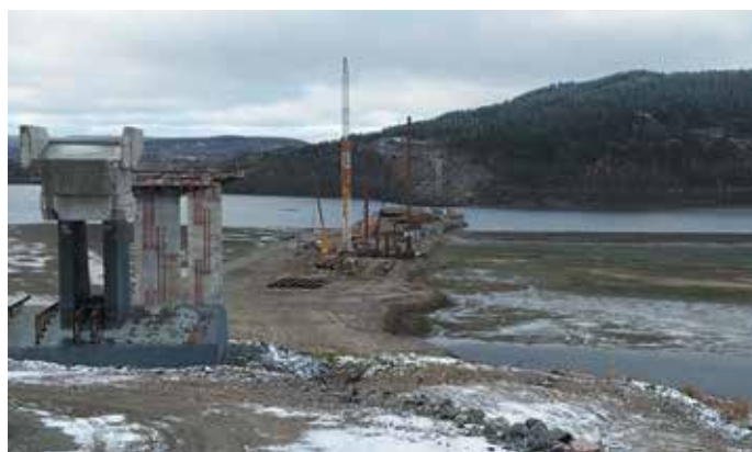
Строительство нового моста через Кольский залив
