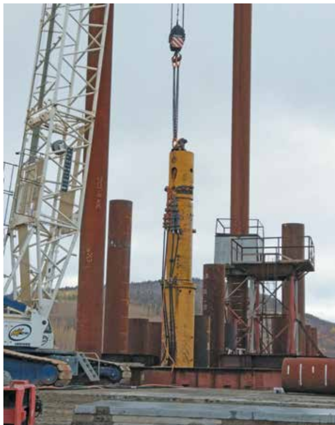
Забивка свай на глубину 76 м при строительстве нового моста через Кольский залив
